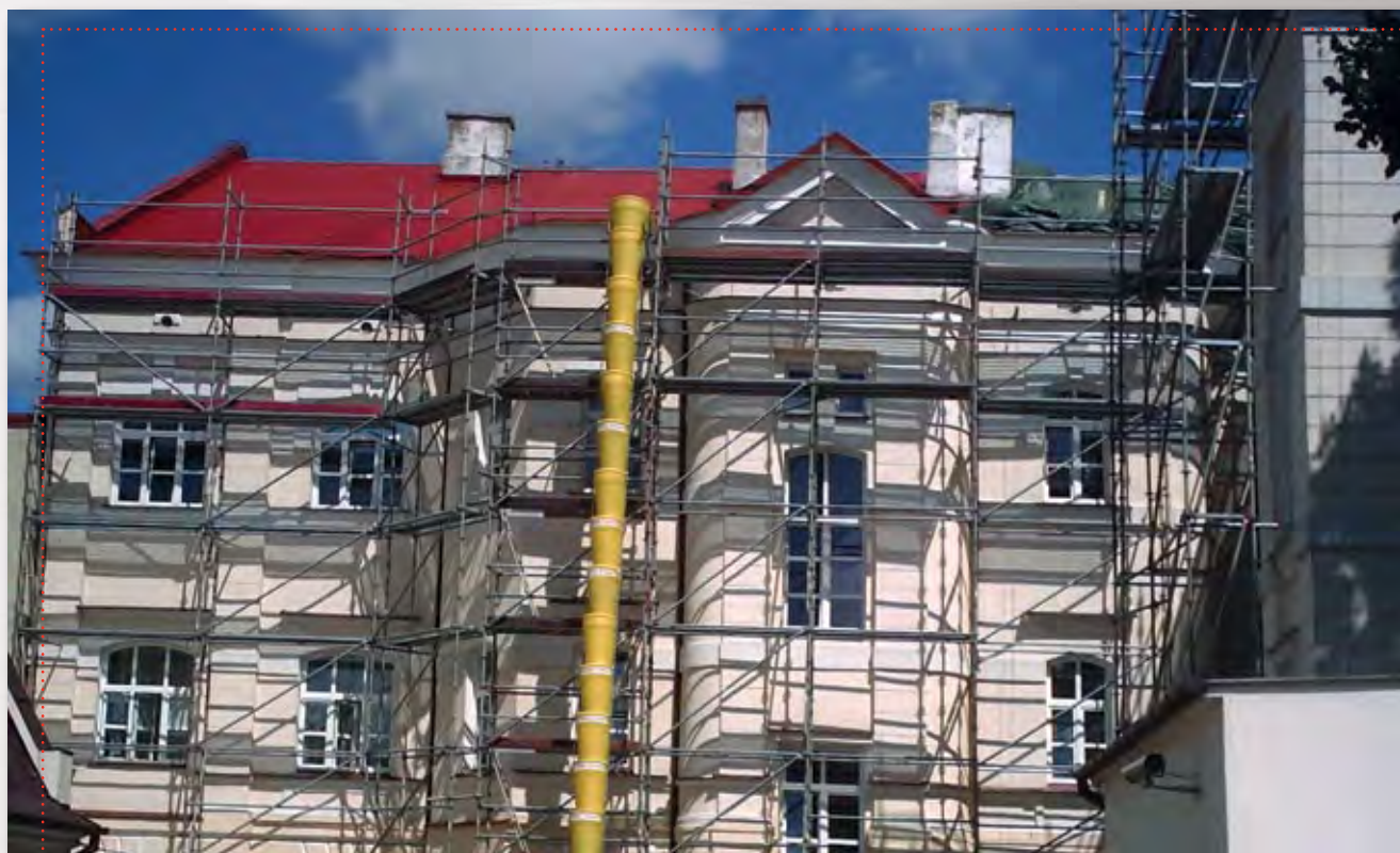
.....Łomża – zsypano budowlane.....
