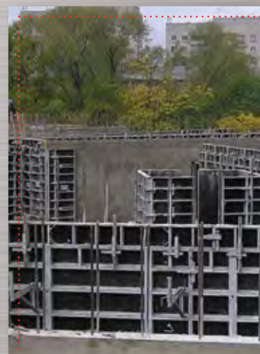
.....Szalunki ścienne – budowa .....
