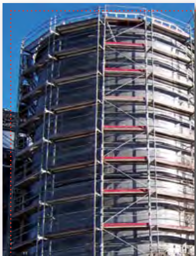
.....Elektrownia w Ostrołęce.....
