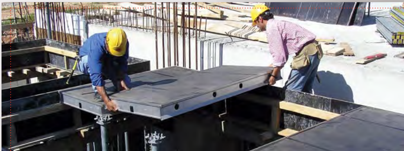
.....Montaż płyt ALUstrop.....
